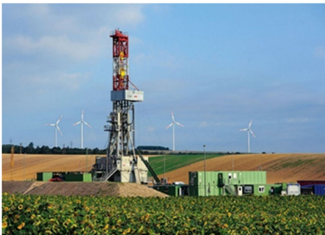
Figuur 5-2: Tijdelijke boorinstallatie.
