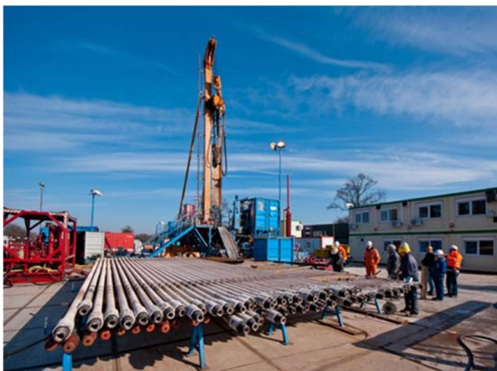
Figuur 3-4: Boormast bij proefboring ISH-01.
